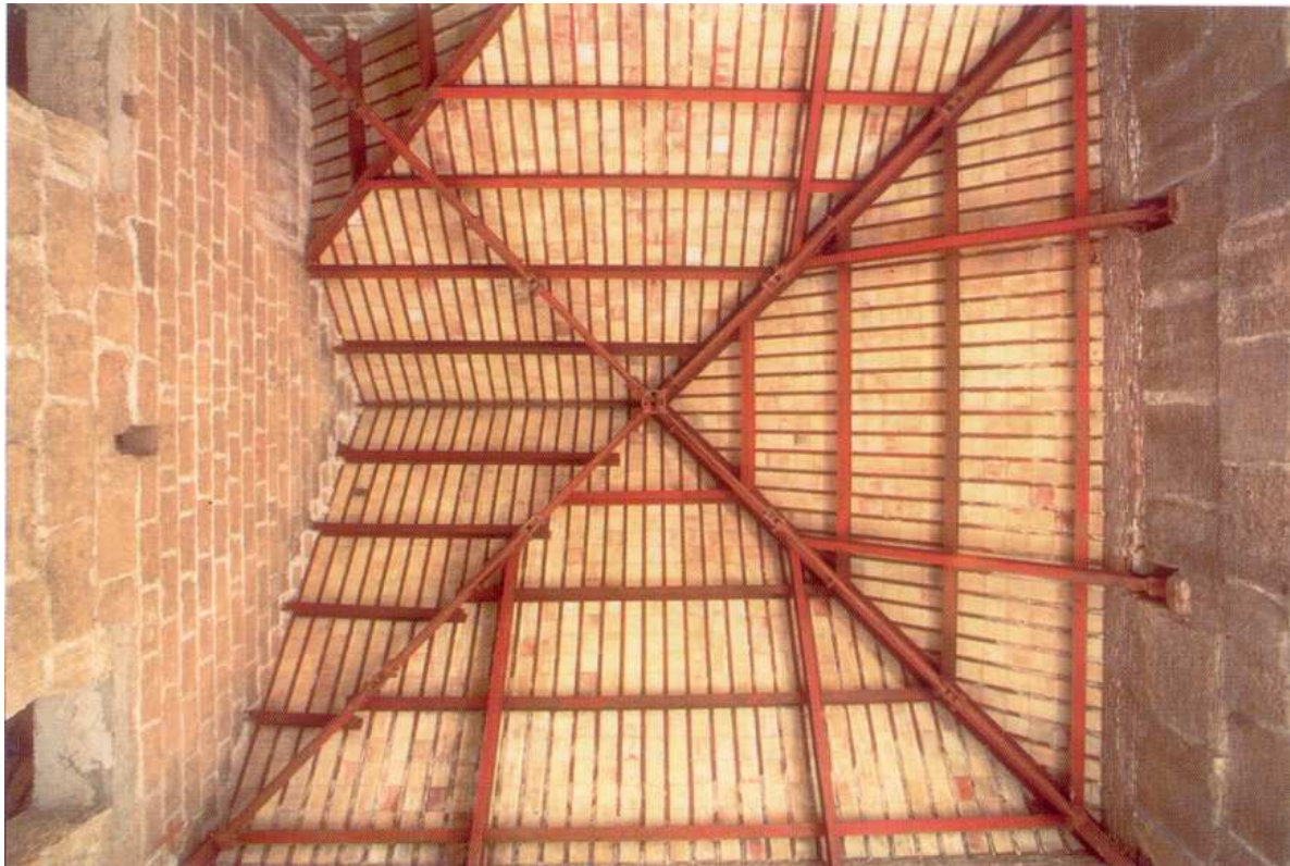
Figura 6: Struttura della copertura dei corpi quadrangolari
