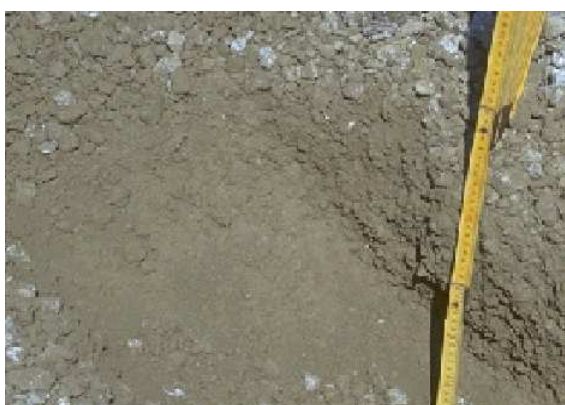
Fig. 3 – Miscelazione grossa 0/40 (sopra) e molto fine 0/20 (sotto).
