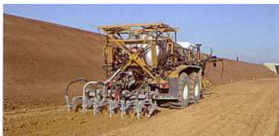
Fig 1 - Umidificazione all'interno dello strato
