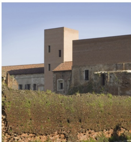
Paolo Zermani, Restauro e ricostruzione del castello , Novara, 2016
